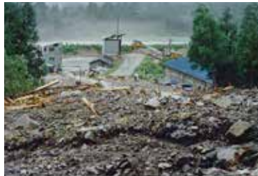
山崩れにより崩壊した工場(板取村)
