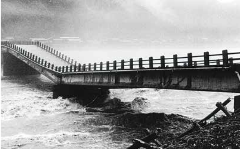
洪水により崩壊した陸橋(美濃市)
