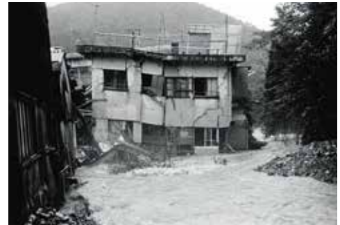
谷川の氾濫で崩壊した家屋(武芸川町)
