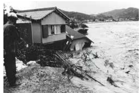
洪水により崩壊した家屋(関市)
