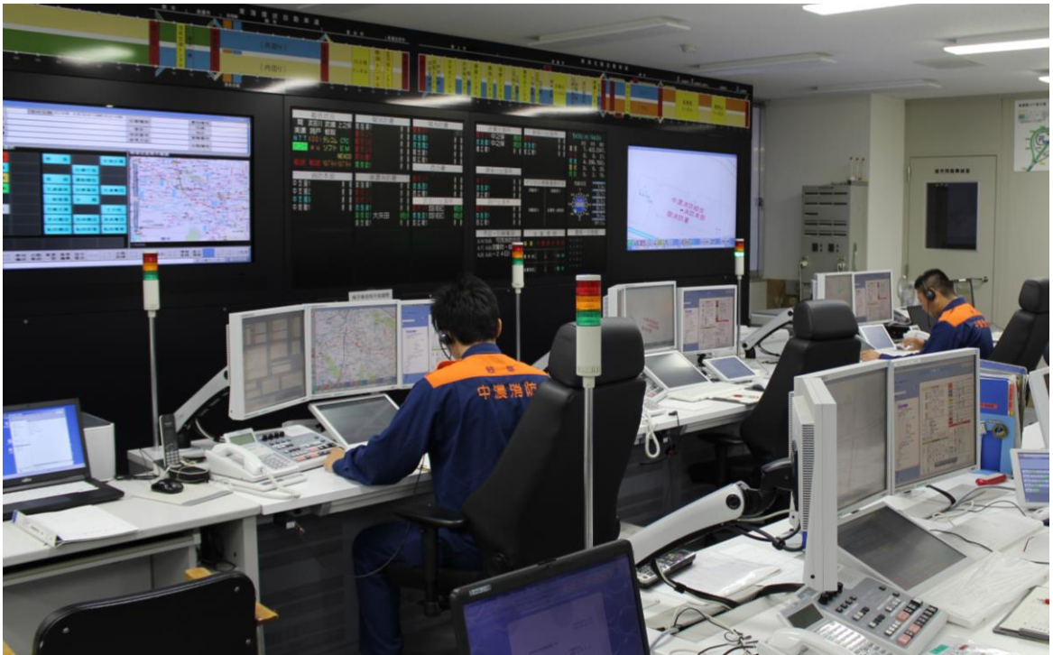
高機能消防指令センター
