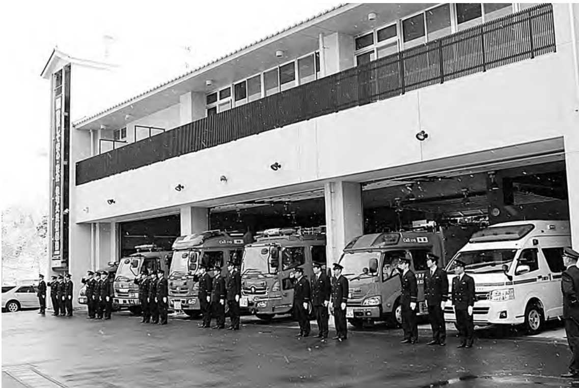
車両点検（美濃消防署）
