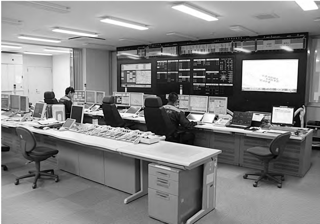
高機能消防指令センター
