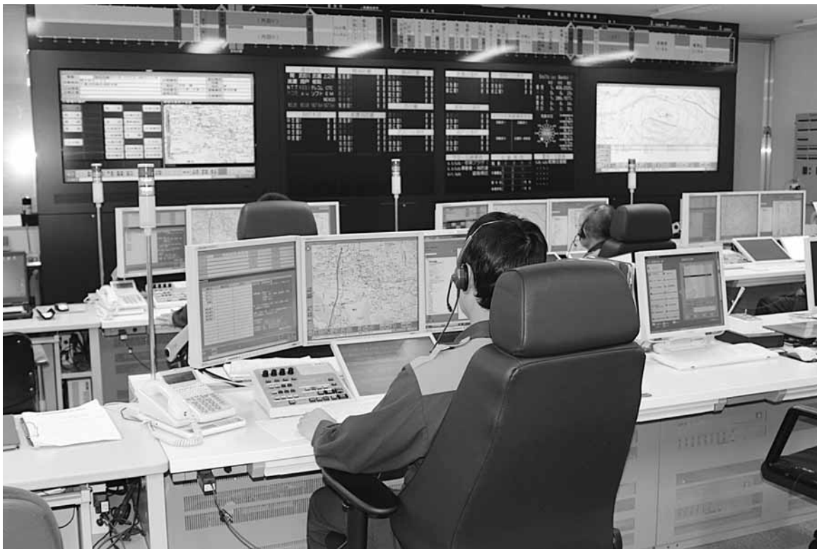
高機能消防指令センター
