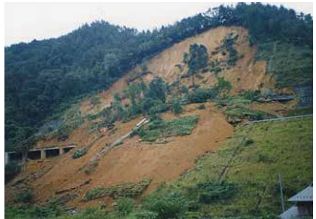
9.15 豪雨により管内各地で被害が発生 (H11)
