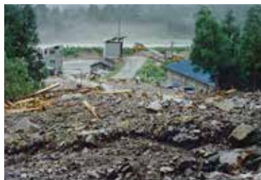
山崩れにより崩壊した工場(板取村)
