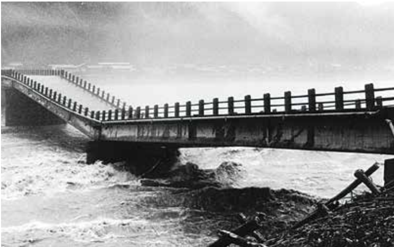
洪水により崩壊した陸橋(美濃市)
