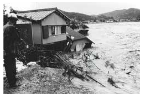
洪水により崩壊した家屋(関市)
