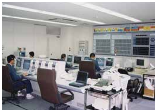
消防緊急通信指令施設（H9）
