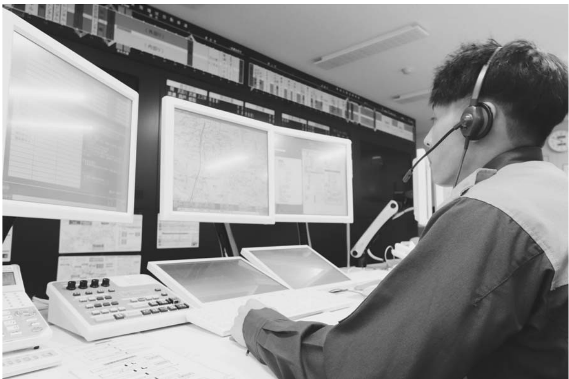
高機能消防指令センター
